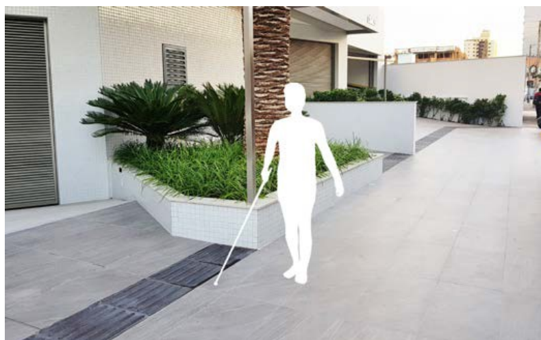
Figura 50. Orientação utilizando piso direcional.
