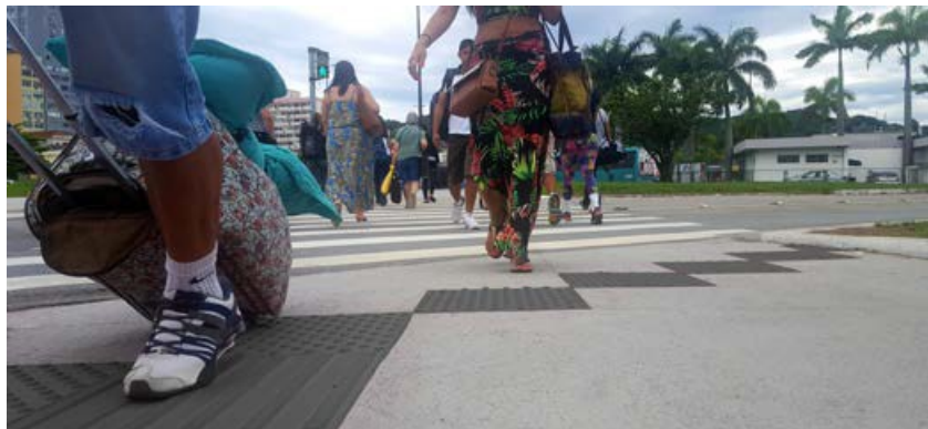
Figura 56. Observe o posicionamento do piso de alerta, escalonado e desenvolvendo-se paralelamente ao meio-fio.
